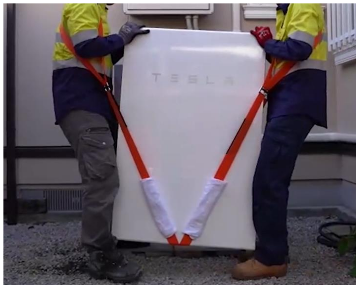
キャリーベルトによる運搬、設置の例
