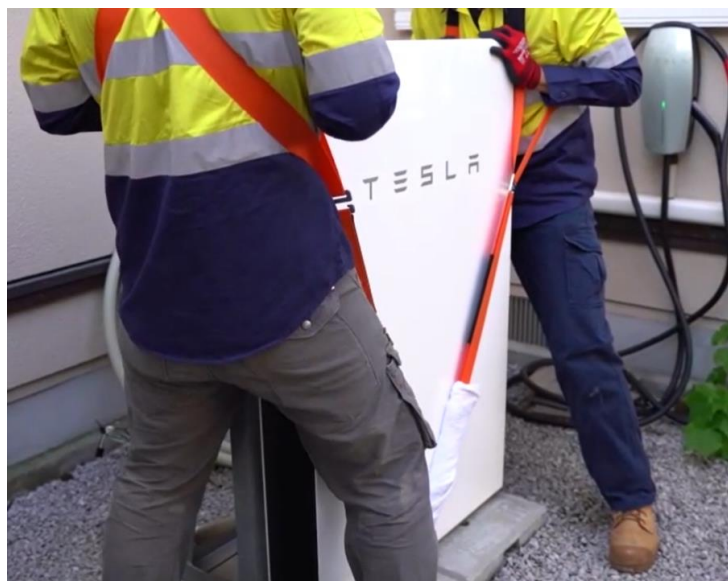
キャリーベルトによる運搬、設置の例
