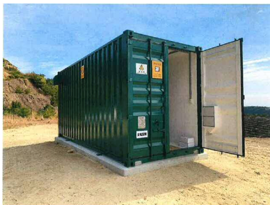
(出典 実績設置 太陽光発電所) 図 2-3-6 受電設備の例
