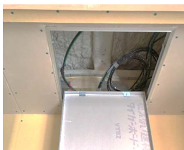
5) 仕上げ工事の際に天井点検口でパワコンまでの接続ケーブルと圧着。
