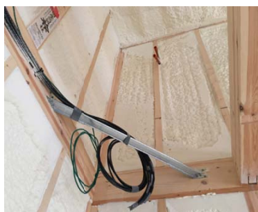
3) パワコンからの分電盤までのケーブルはウレタン吹付け前に施工します。
