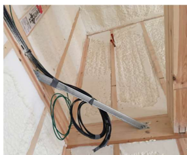
3) パワーコンからの分電盤までのケーブルはウレタン吹付け前に施工します。
