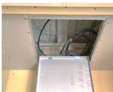
5) 仕上げ工事の際に天井点検口でパワーコンまでの接続ケーブルと圧着します。
