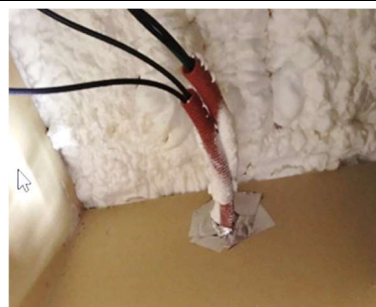
4) ウレタン吹付け後に小屋裏にケーブルを引き込みます。
