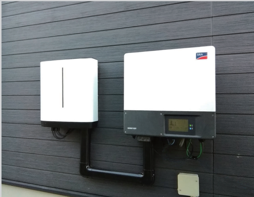
パワーコンディショナとDC/DCコンバータ
