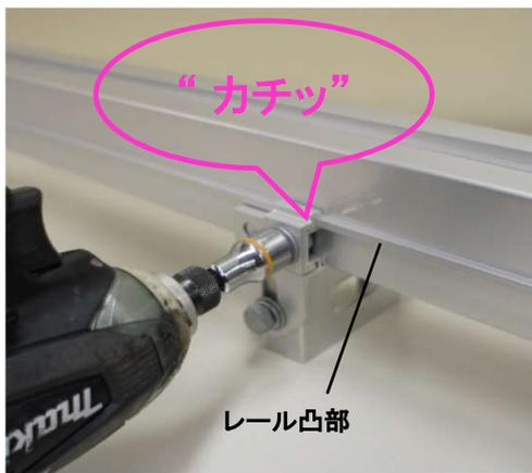
② 徐々にM8×18ボルトを締付けるとサイドプレートがレール凸部に食い込み“カチッ”と音が鳴ります。
