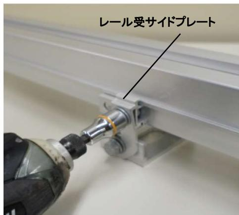
① レール受サイドプレートのM8×18ボルトを締付けます。締付け前はサイドプレートが上の写真のように斜めに浮いた状態を確認してください。(工場出荷時の状態)
