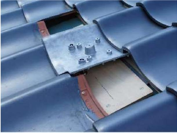
瓦を葺き返した後に、プラスのドライバーで高さ調整ボルト(アジャスターボルト)を回転させる事で、瓦の高さ調整が簡単にできます。
